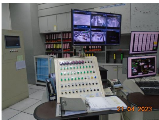
ภาพที่ 2.1-35 Interlock System และ Alarm Annunciator
